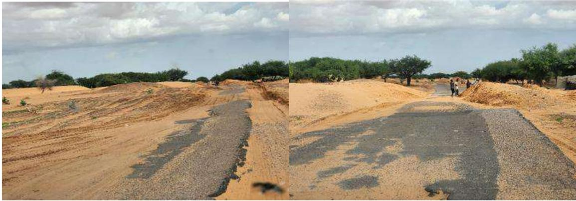
Photo 1. Illustration des risques d'érosion hydriques et/ou éolienne aux droits des ouvrages et infrastructures routières
