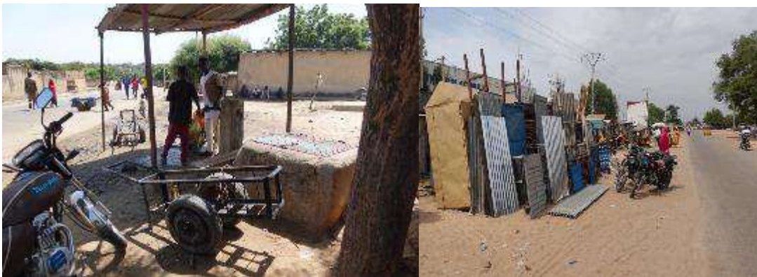
Photo 4 : Borne fontaine à gauche et à droite Matériaux de construction sur la voie à Tibiri-Maradi
