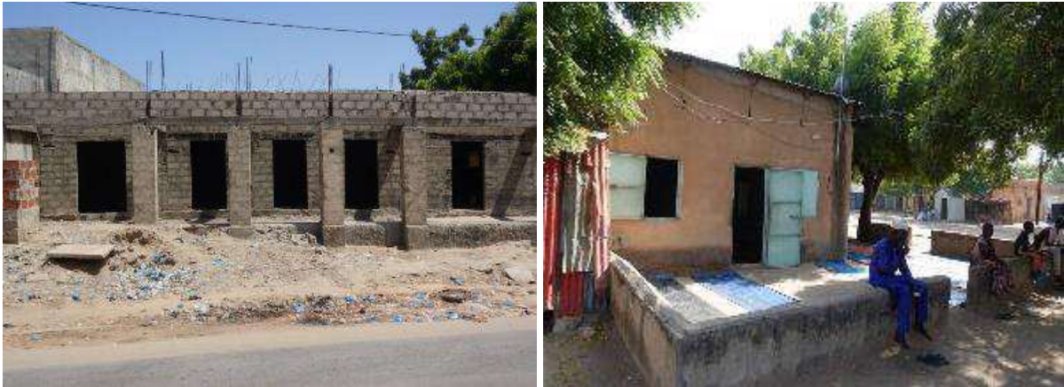
Photo 3 : Construction en cours à Maradi à gauche et à droite une mosquée à la Patte d'oie
